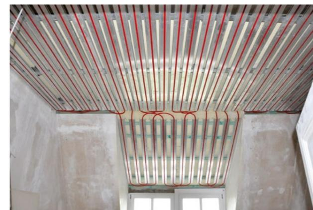
Wärmedecken lassen sich ohne großen Aufwand montieren
