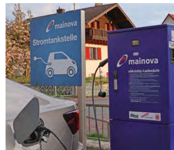
Glashüttener Stromtankstelle am Bürgerhaus
